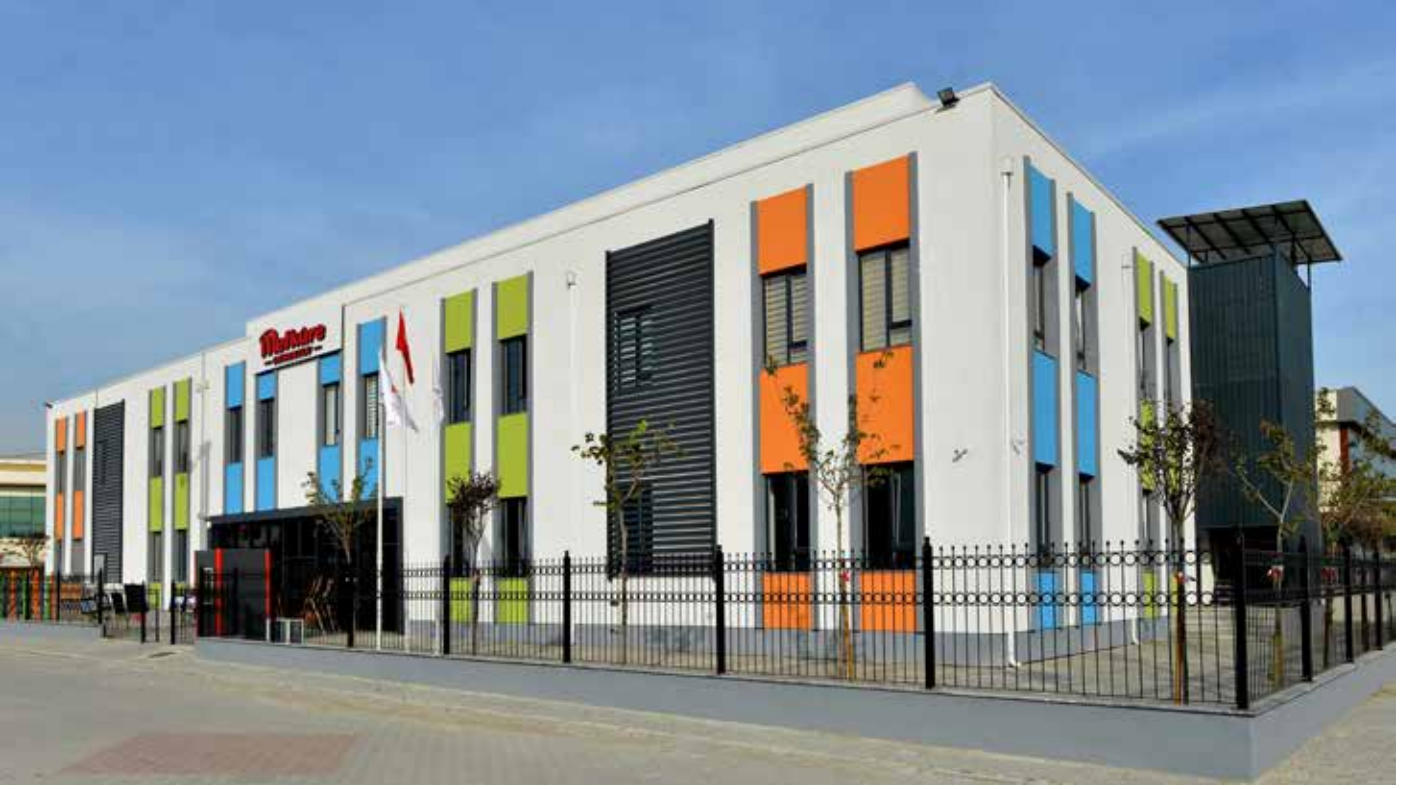
Özel Ortaokul Yapım İşi
