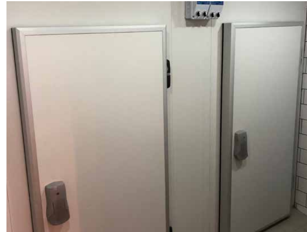
Soğuk Hava Deposu
