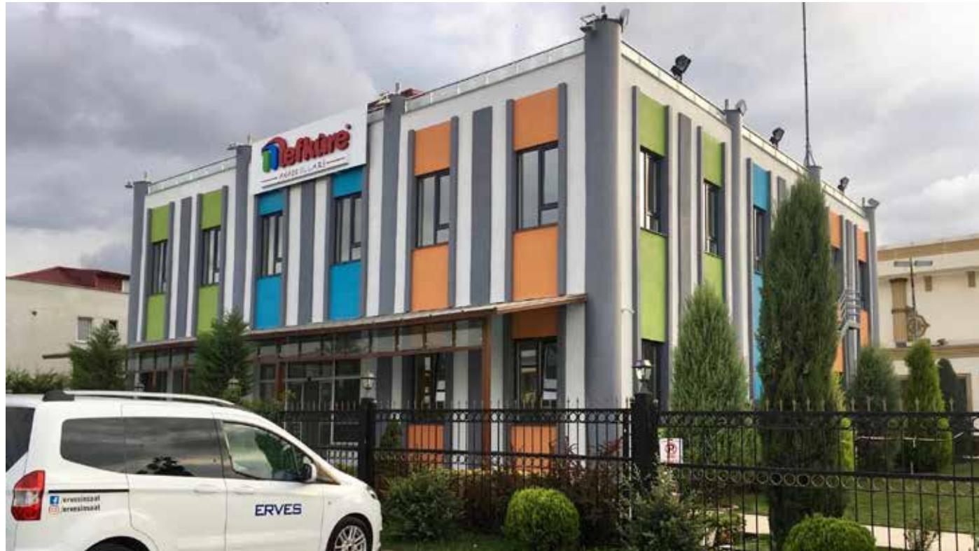
Özel Anaokulu Renovasyonu
