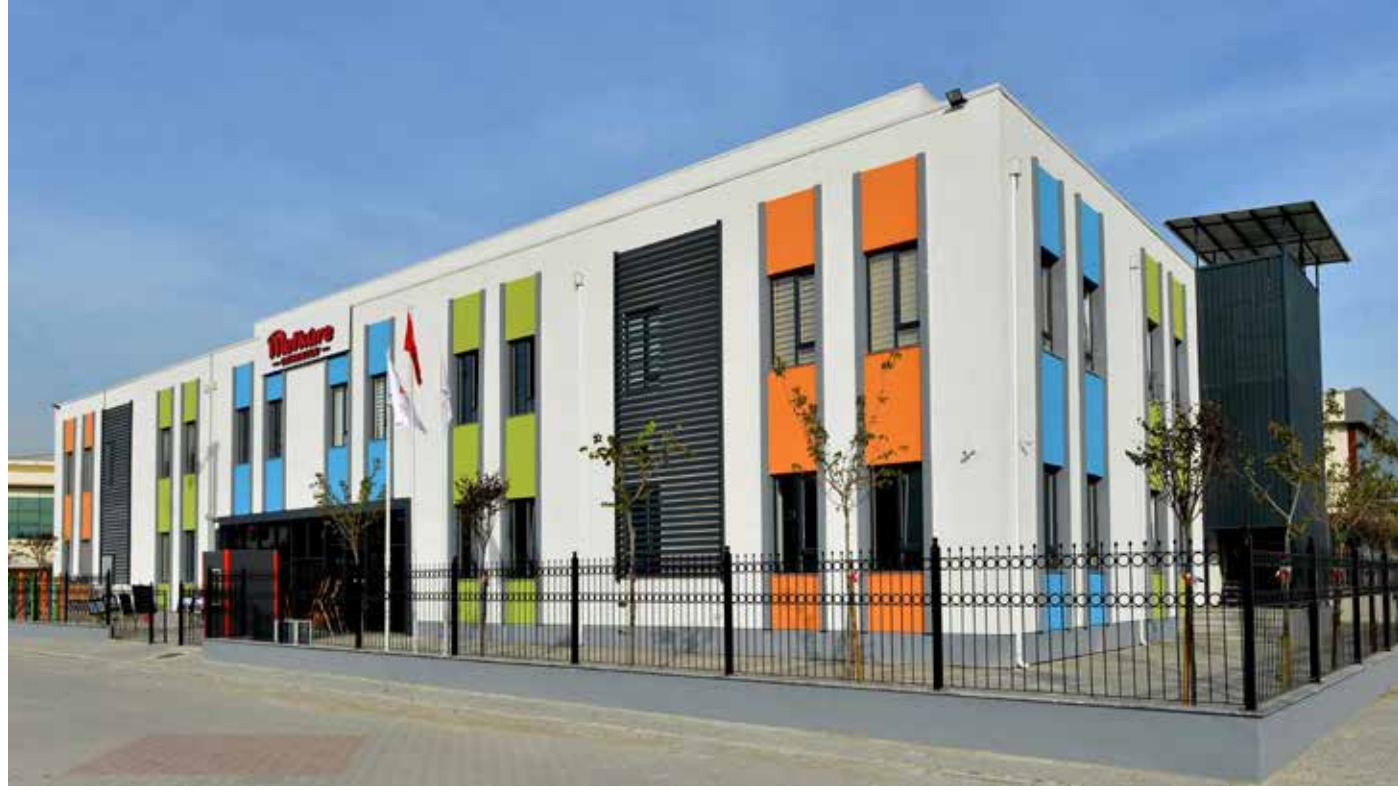
Özel Ortaokul Yapım İşi
